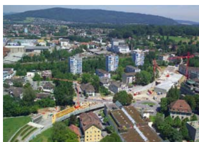
Verkehrssanierung Lenzburg mit Kernumfahrung, 1994 bis 2006
