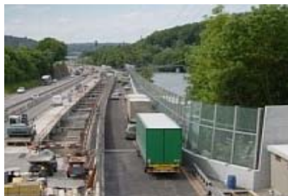
Sanierung Autobahn A1, Baden bis Kantons-grenze AG/ZH, 2005 bis 2008
