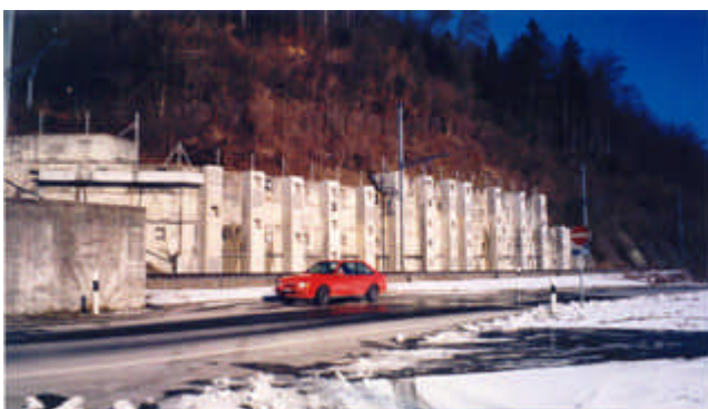
Verstärkung Loppertunnel Südportal
