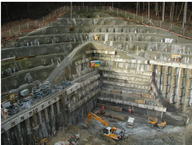
Voreinschnitt Nord Islisbergtunnel, Hangsicherung mit Verankerung und Bohrpfahlwänden
