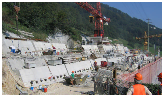
Verstärkung Portalstützwände Borntunnel, Verankerung oberhalb den Wänden
