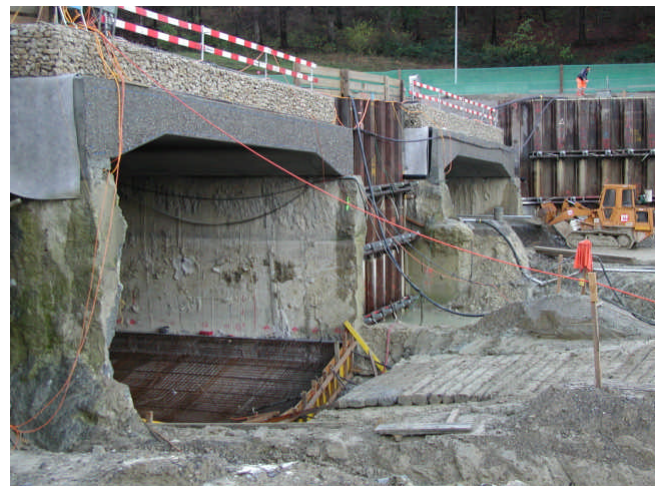
Voreinschnitt Nord Islisbergtunnel, Tagbaustrecke in Deckelbauweise
