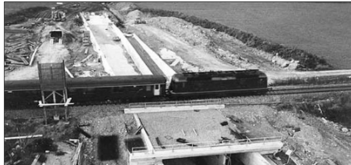
Unterführung und Grundwasserwanne Längenbold, Root LU
