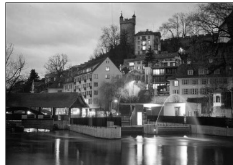
Kraftwerk Mühlenplatz, Luzern
