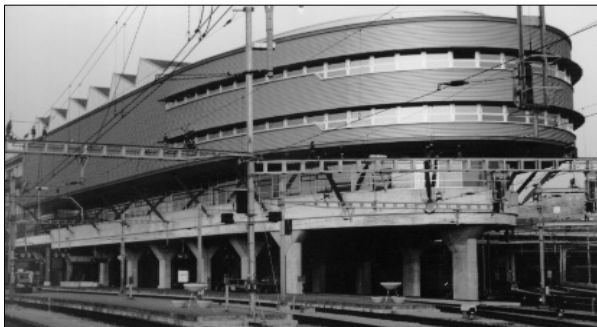
Gewerbeschulzentrum Bahnhof Luzern, Turnhallen-Trakt
