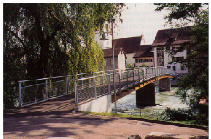
Widerlager und Pfeiler der Reussbrücke, Mellingen
