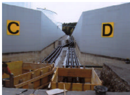
Werkleitungsbau Tankanlagen, Mellingen
