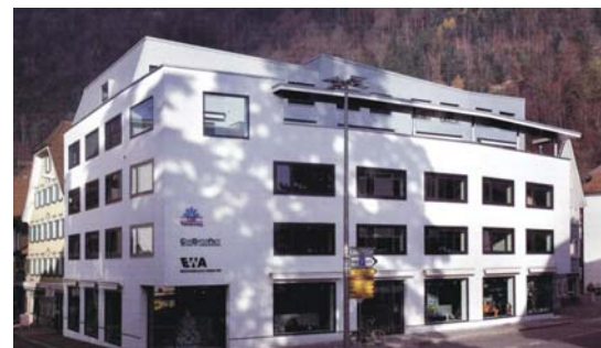
Neubau Geschäftshaus Krone, Altdorf
