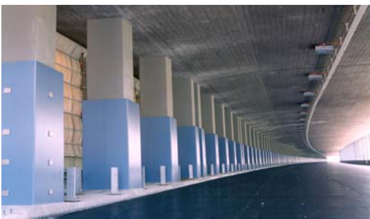
Instandsetzung A2 Kanton Uri, Galeriestütze
