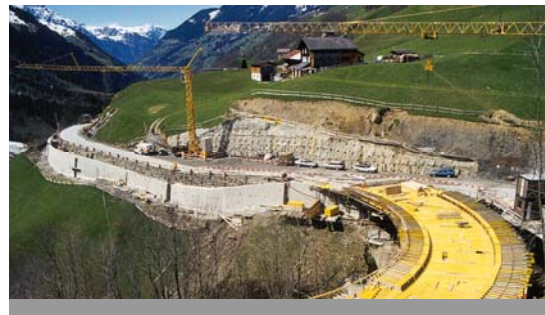
Ausbau Klausen-Passstrasse, Spiringen-Unterschächen
