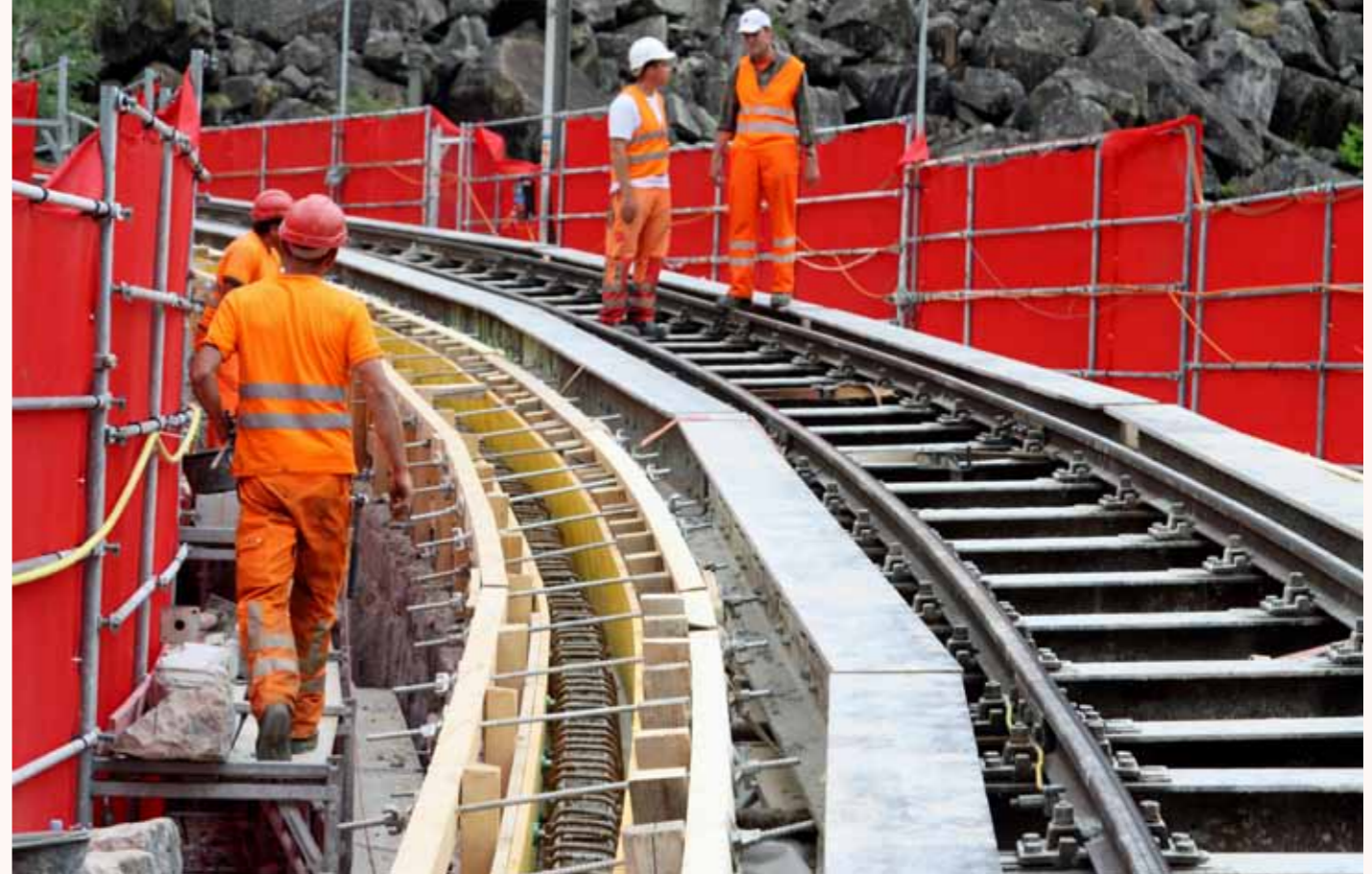
Sanierungsarbeiten unter laufendem Betrieb am RhB-Kreisviadukt in Brusio. Bild: zvg
